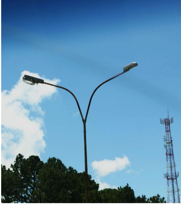
A la izquierda, farola contaminante. A la derecha, farola no contaminante. Ambas dispuestas de manera contaminante en una
